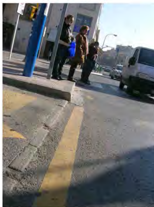
Acera sin rebaje
